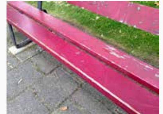
Schade aan het bankje door het beskat' ervan. Ook is te zien dat de oorspronkelijke verf niet meer in goeie staat is en afbladdert
